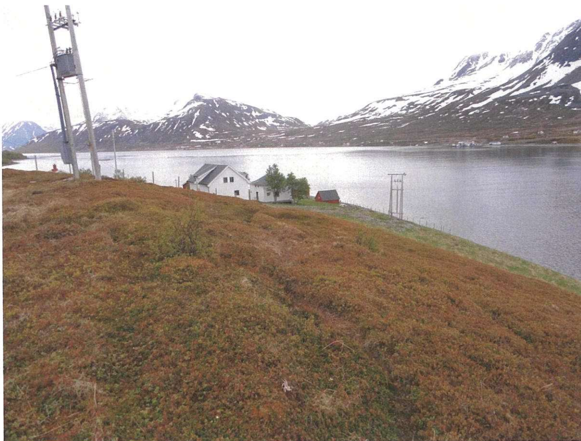
Småbruket Brattvoll sett mot sør.
