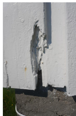
Råteskadet trekledning som er forsøkt reparert
