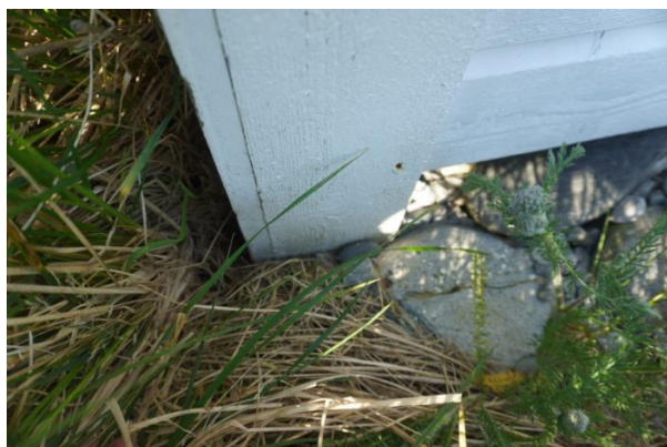
Kledning rundt terrasse går helt til terreng.
