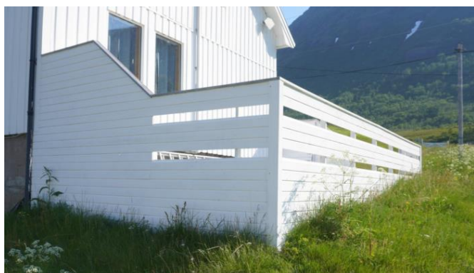
Trekledning rundt terrassen går helt ned til terreng
