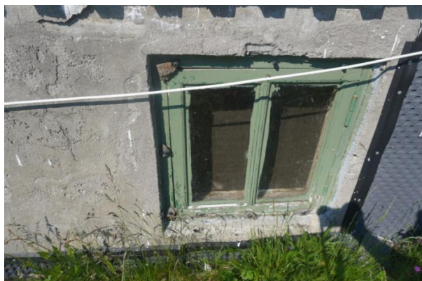
Eldre vinduer i kjeller
