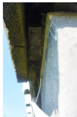
Noen åpninger bakom trekledningen
