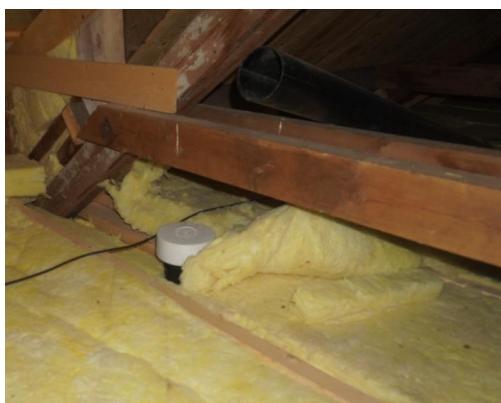
Durgoventil/lufting på kaldloftet
