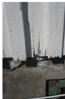
Råteskadet trekledning som er forsøkt reparert
